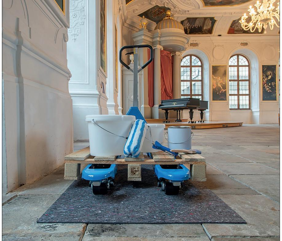
Abgedeckter Bodenbelag mit Schutzlegeboden (Hammerfest EXTRA) in denkmalgeschützten Räumen für Arbeiten mit schweren Lasten.
