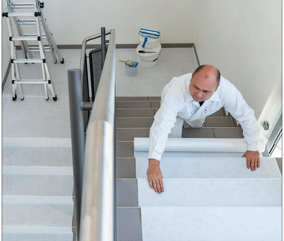
Das selbsthaftende Abdeckvlies NOWOpro® SHV 200 BG mit DGUV Test-Zeichen ist nach GS-IFA-B02 für Böden und Treppen zertifiziert. (Fotos: NOWOTEX)
